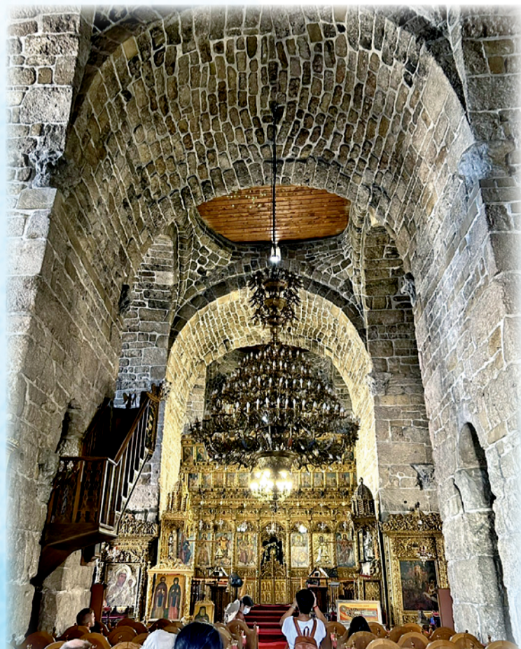
▲圖4：被削去圓頂的拉匝祿堂以木板填平天花板，並沒有去修復它；聖堂內部的木質聖像畫屏金碧輝煌，引人細賞默觀。
